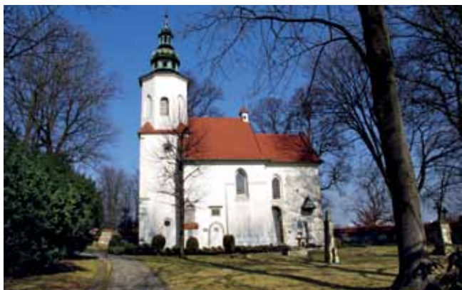
Kościół pw. św. Salwatora na Zwierzyńcu
