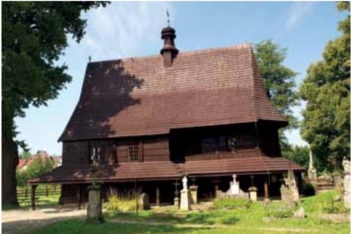
Kościół pw. św. Leonarda w Lipnicy Murowanej
